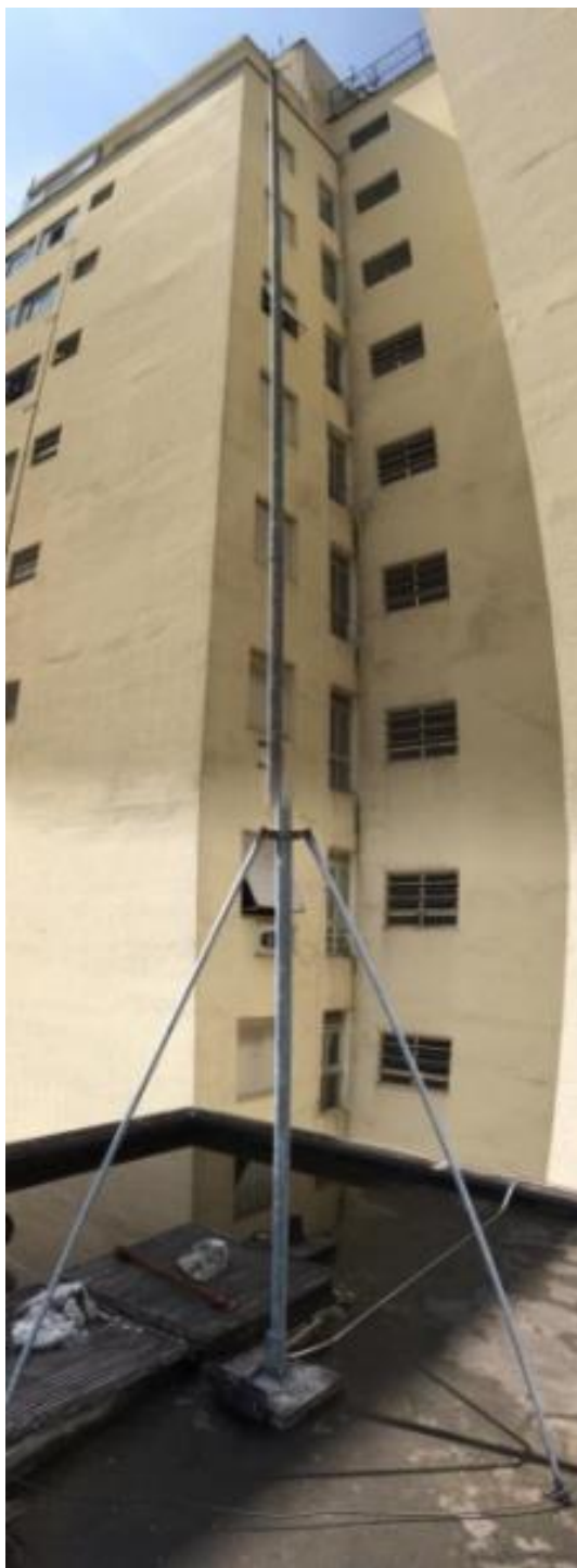
Figura 52 –SPDA, no detalhe a haste do sistema Franklin (Fonte: Arquivo Pessoal, 2014)
