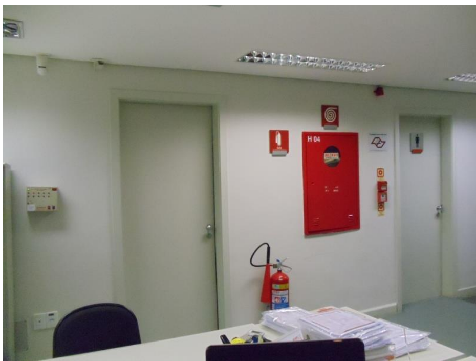
Figura 43 – Falta de Sinalização de rota de fuga
