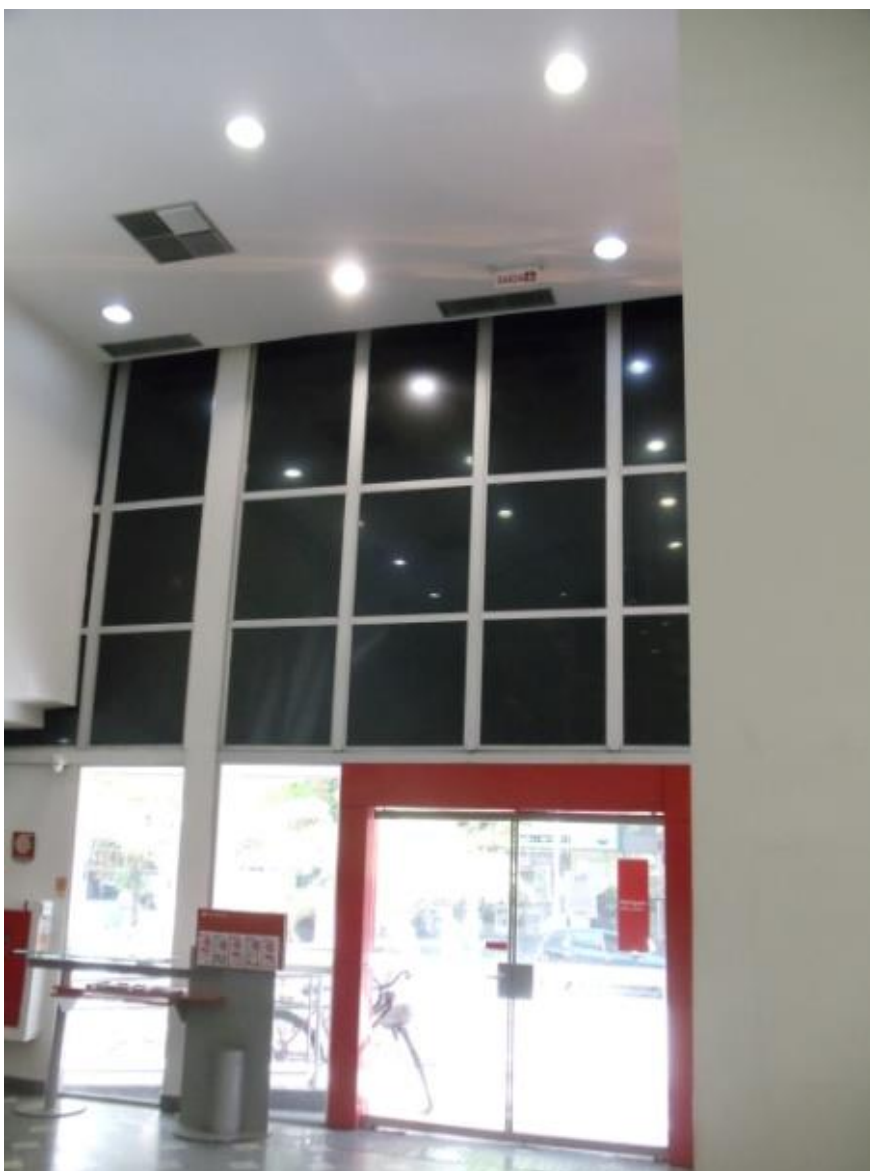
Figura 37 – Sinalização de saída de emergência com altura fora da norma, devendo ser colocado placa verde fotoluminescente junto ao pórtico.
