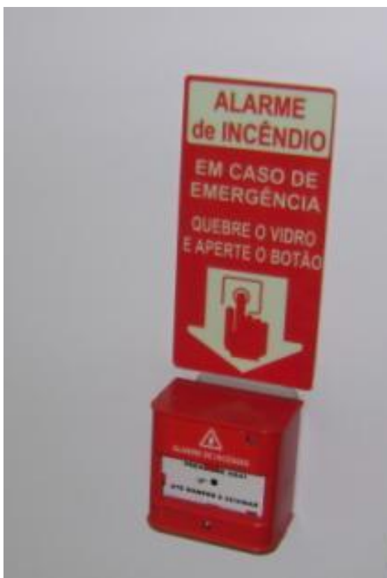
Figura 46 – Botoeira do tipo quebra vidro (Fonte: Arquivo Pessoal, 2014)
