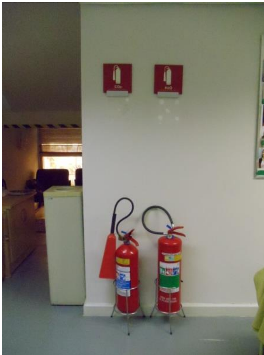
Figura 35 – Extintores classe B e C (Fonte: Arquivo Pessoal, 2014)
