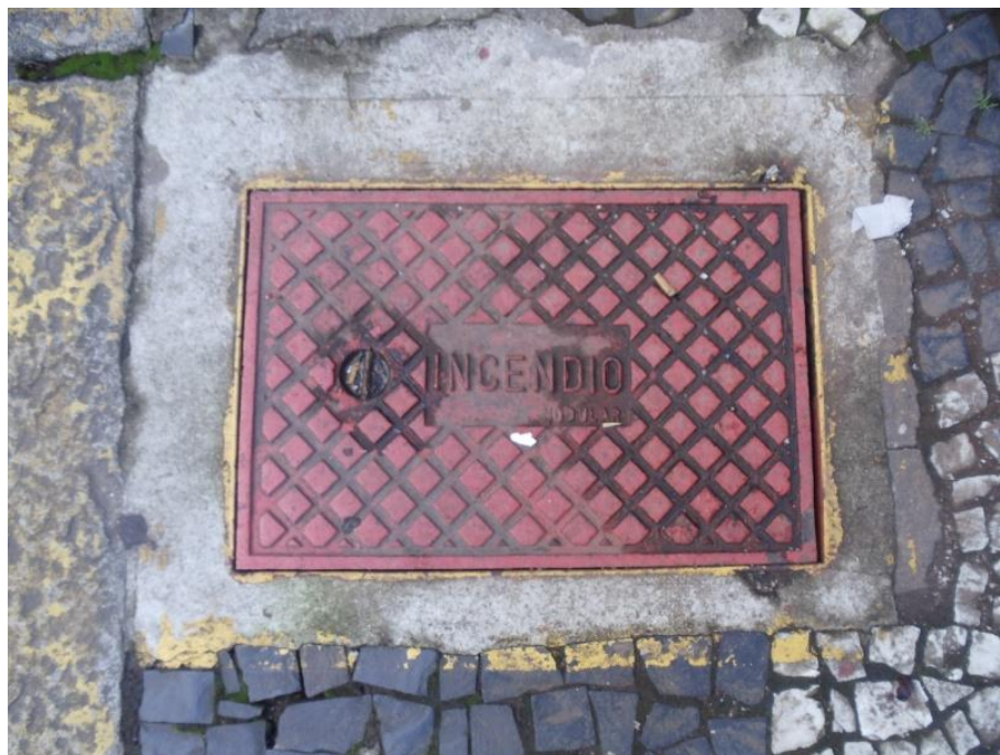
Figura 59 – Registro de recalque com a porta emperrada (Fonte: Arquivo Pessoal, 2014)
