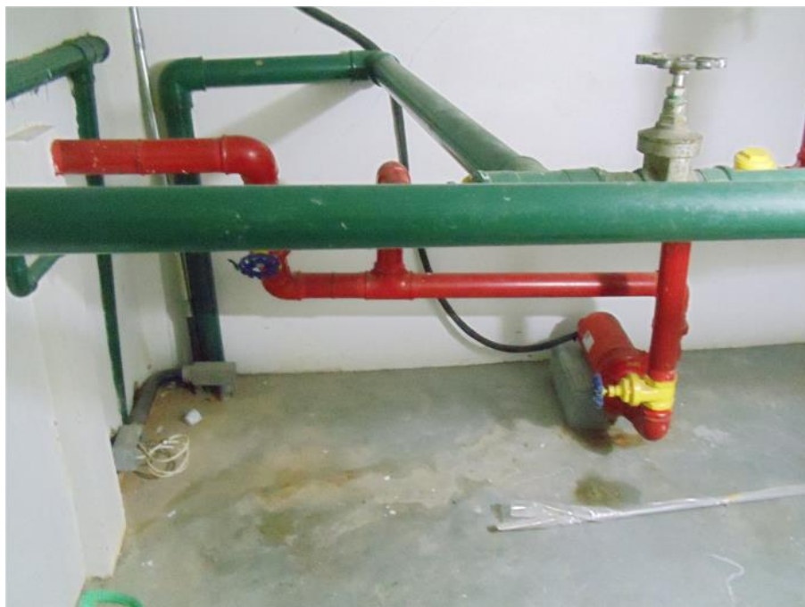
Figura 57 – Detalhe do barrilete com a bomba de incêndio (Fonte: Arquivo Pessoal, 2014)
