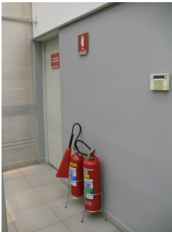
Figura 38 – Falta de Sinalização de Emergência e um dos extintores (Fonte: Arquivo Pessoal, 2014)
