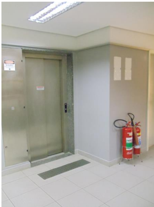
Figura 44 – equipamentos sem Sinalização de Emergência (Fonte: Arquivo Pessoal, 2014)
