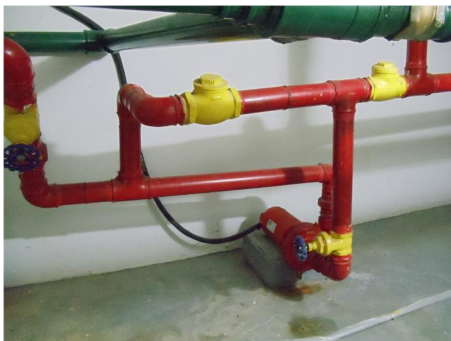
Figura 58 – Detalhe da bomba de incêndio (Fonte: Arquivo Pessoal, 2014)
