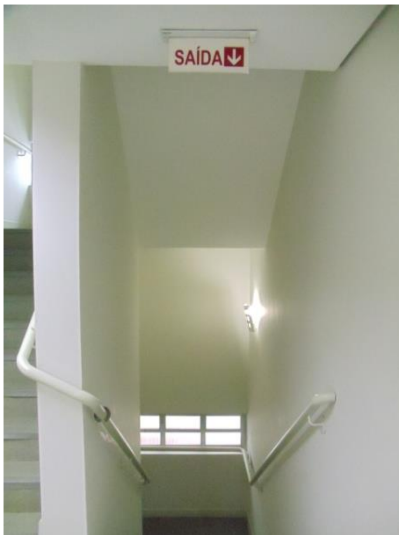
Figura 36 – Detalhe da falta de iluminação de emergência na escada principal (Fonte: Arquivo Pessoal, 2014)
