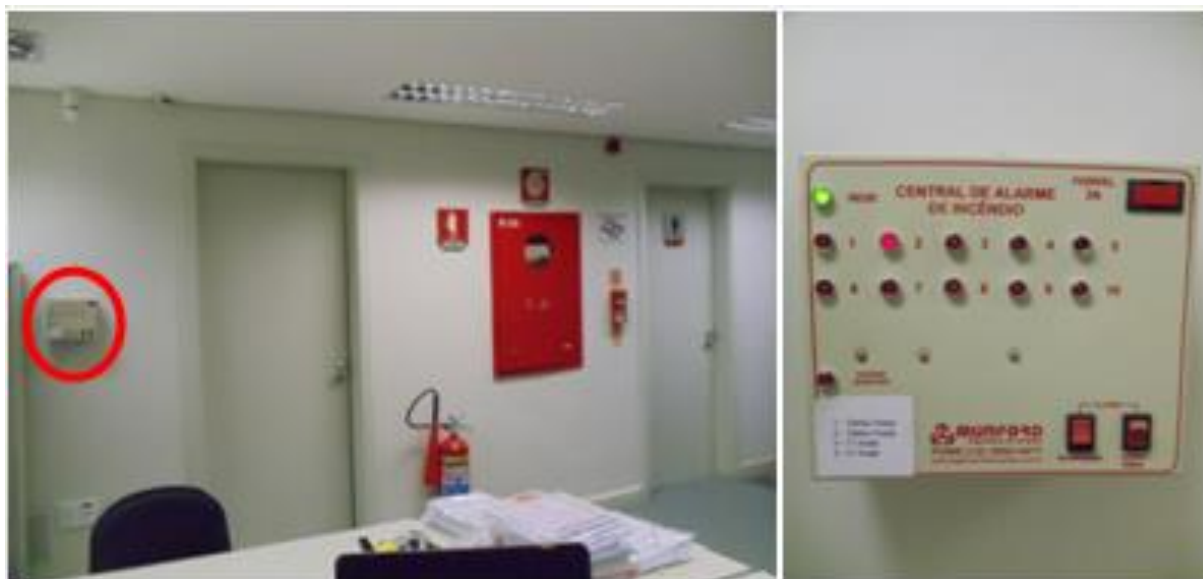
Figura 47 – Central de Alarme de Incêndio sem as baterias externas
