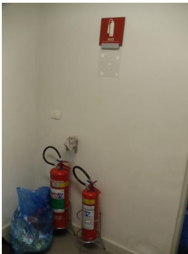
Figura 42 – Falta de Sinalização de Emergência e um dos extintores, observado lixo próximo ao equipamento, obstruindo seu uso.
