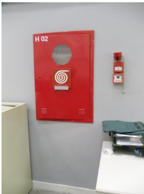
Figura 56 – Detalhe do hidrante localizado no mezanino, necessário corrigir Sinalização e desobstruir seu acesso.
