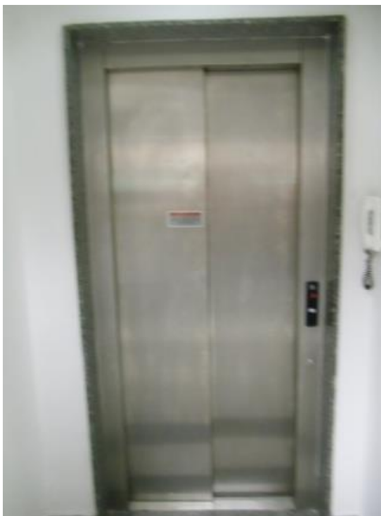
Figura 40 – Falta da placa informativa de segurança “Em caso de incêndio não uso o elevador” nos três pavimentos.
