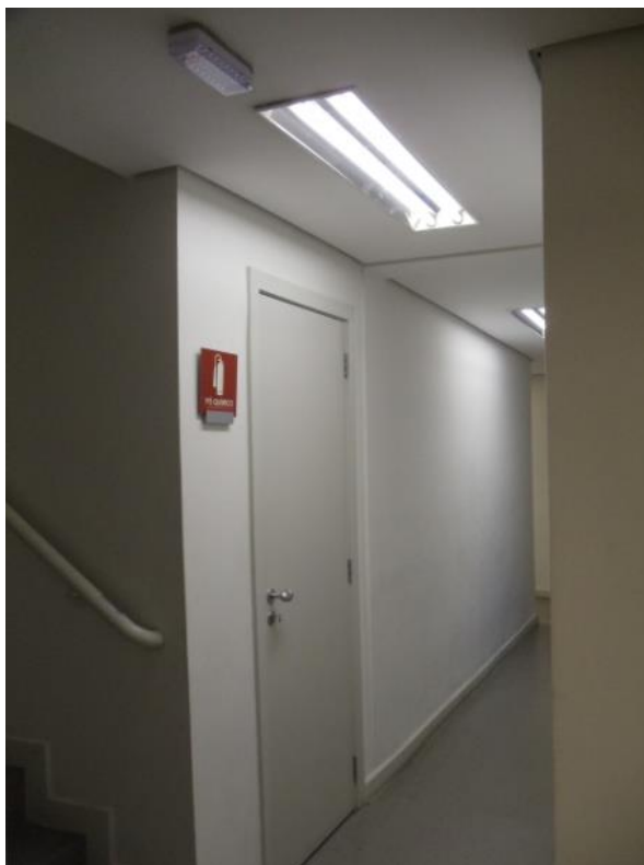
Figura 41 – Placa de Sinalização de extintor incorreta e falta de indicação de rota de fuga
